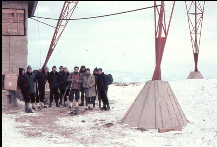
PO OPRAVLJENI MONTAŽI, dec. 1962
