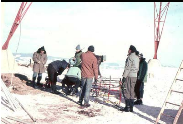
MONTAŽA DODATNE OPREME, dec. 1962
